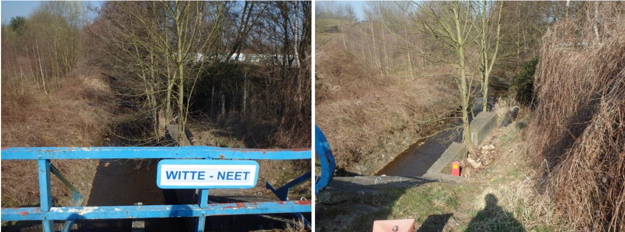
Foto 6: bagger- + HS-leidingen Sibelco
