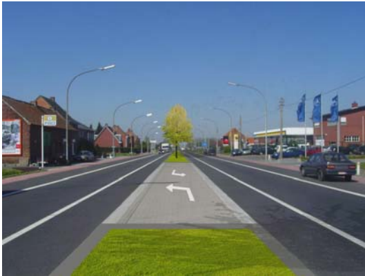
Simulatie N10 Koningshooikt - aanpassing overrijdbare middengeleider
